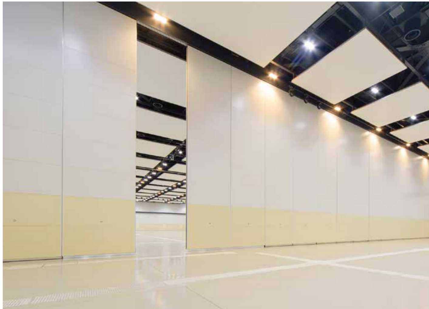
間仕切を利用することで、展示会とセミナー、商談、会議、レセプションなど複合催事の開催に対応できます。(2分割、3分割が可能)
